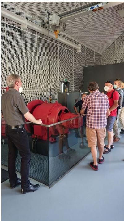
Die ebenso knallrot gestrichene Kaplan-Turbine und der Generator aus dem Jahre 1957 wurden mehrfach erneuert, aber das Konzept ist geblieben. Das Wasser der Nagold treibt einen Generator mit einer Leistung von 220 Kilowatt (kW) an. Jährlich werden so ohne Kohlendioxid-Ausstoß eine Million Kilowattstunden (kWh) Strom erzeugt. Hier ist die Zukunft der regenerativen Stromerzeugung schon früh angekommen.
